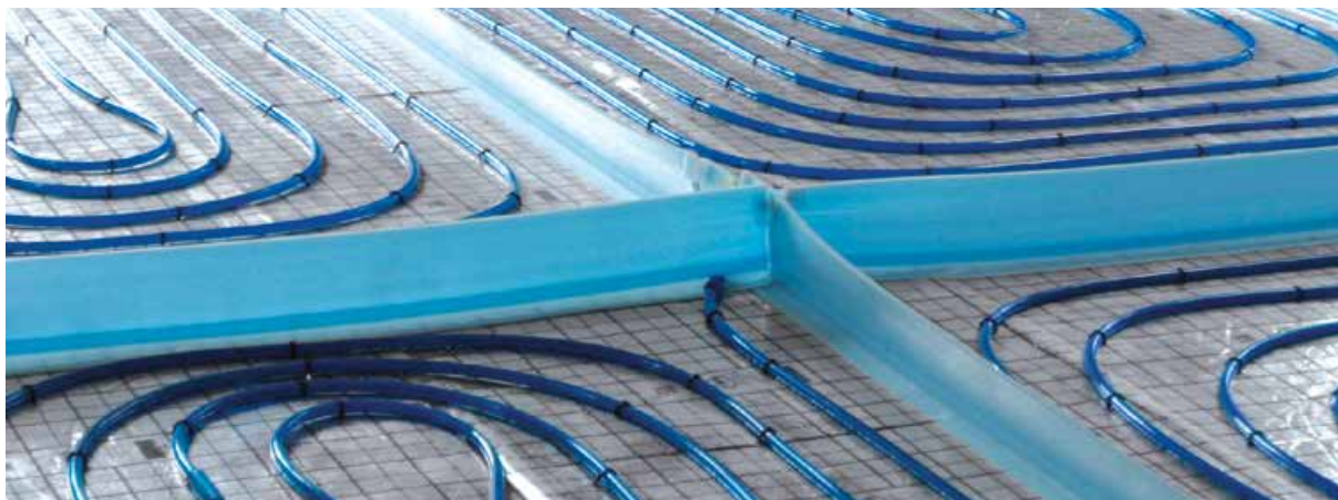
Фиг. 14. Разделяне на нагревните плочи с дилатационни фуги
