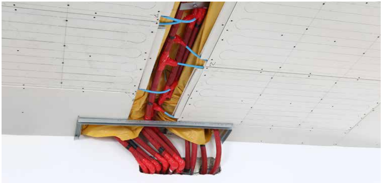
Фиг. 6. Таванна охладителна инсталация с отоплителни и охлаждащи панели на системата KAN-therm Wall.
