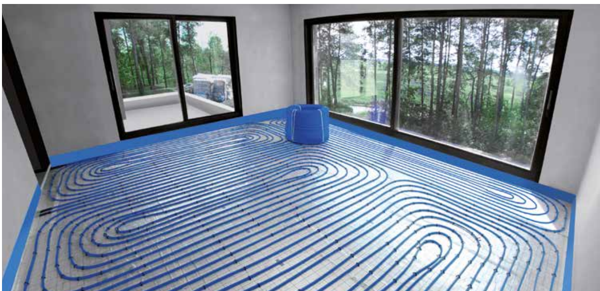
Фиг. 3. Монтаж на подово отопление в еднофамилна сграда с тръби bluePERT и система KAN-therm Tacker.
