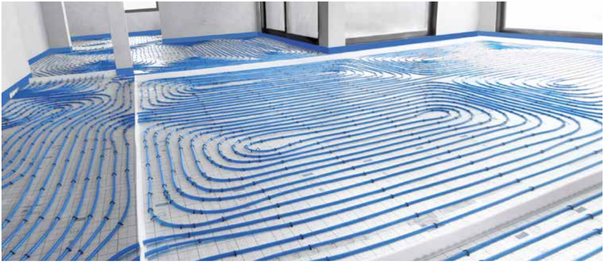
Фиг. 25. KAN-therm Tacker система за подово отопление/охлаждане.
