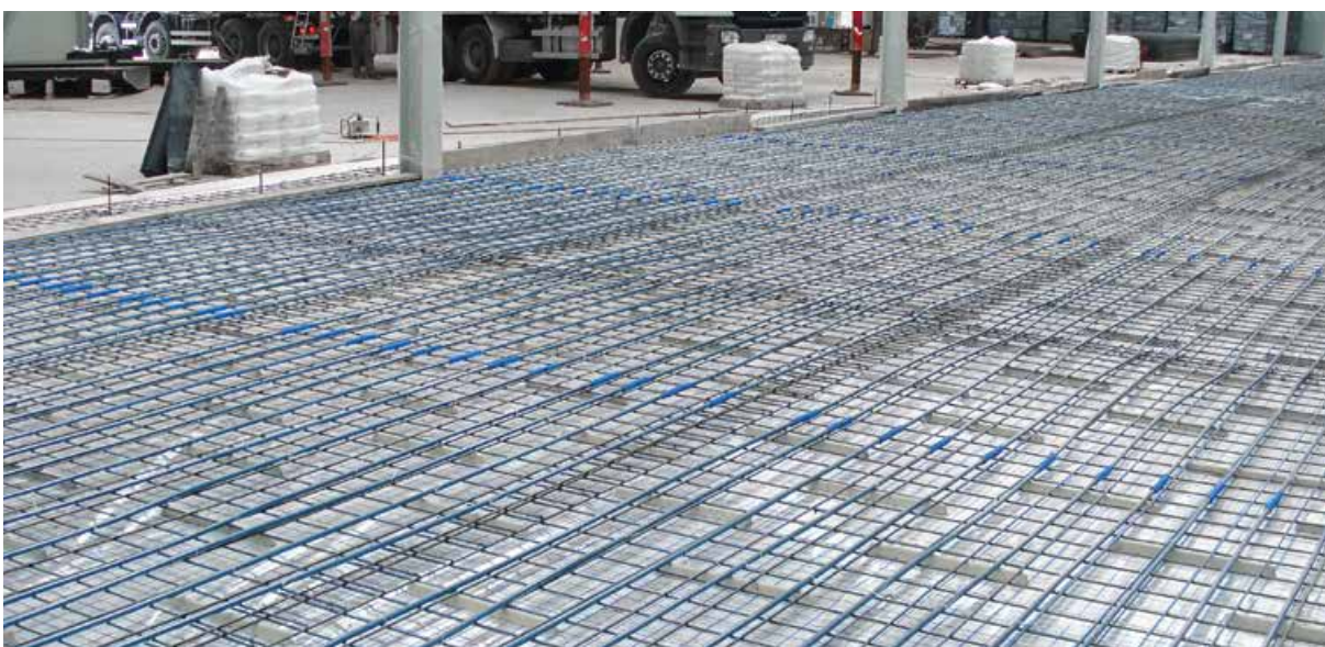
Фиг. 4. Монтаж на подово отопление в промишлено съоръжение с тръби bluePERT и система KAN-therm NET.
