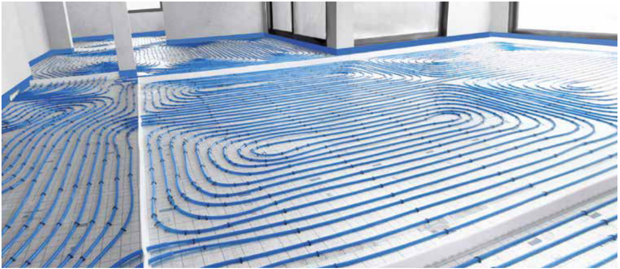
Фиг. 25. KAN-therm Tacker система за подово отопление/охлаждане.
