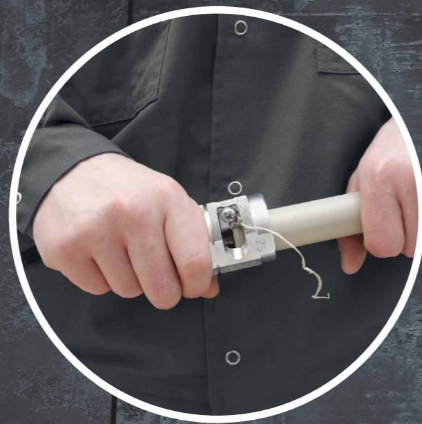
02 Отстраняване на алуминиевото фолио със скрепера (приложимо за PPR композитен тръбопровод stabiAL).
