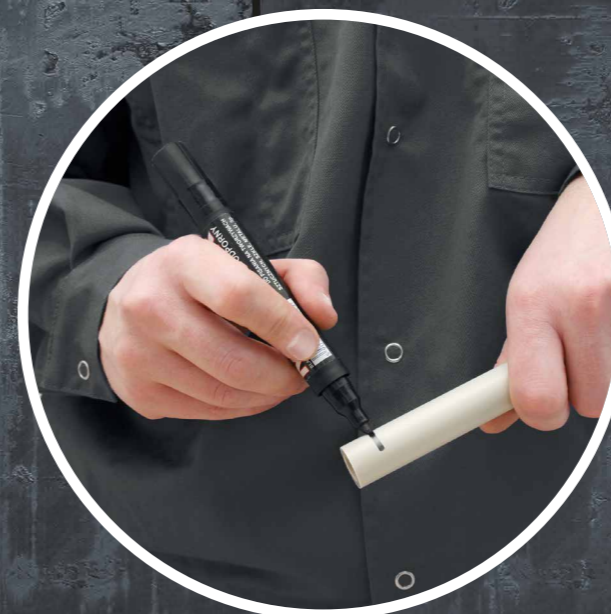
03 Маркиране на дълбочината на заваряване.
