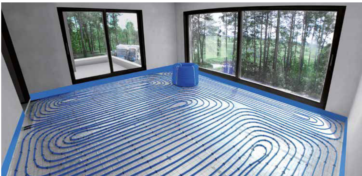
Фиг. 3. Монтаж на подово отопление в еднофамилна сграда с тръби bluePERT и система KAN-therm Tacker.
