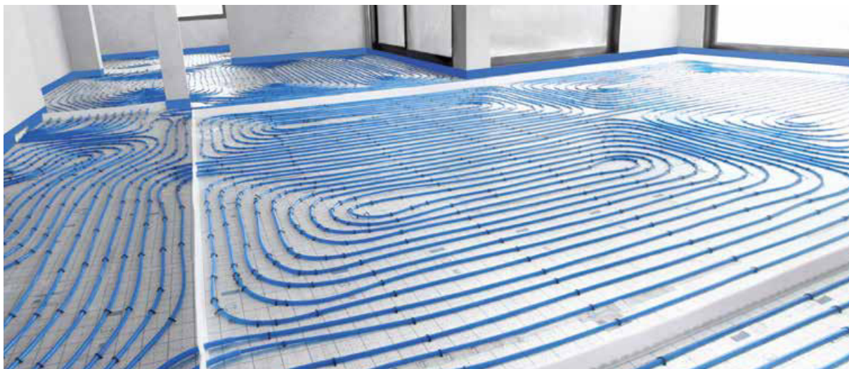
Фиг. 25. KAN-therm Tacker система за подово отопление/охлаждане.
